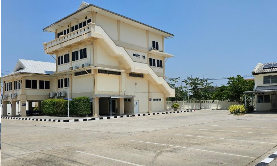
ที่จอดรถยนต์ ด้านหลังอาคารที่ทำการ (หน้าสวนหย่อม)
